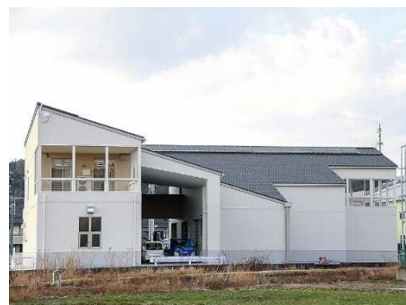
▲拠点防災倉庫
