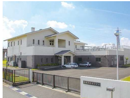
▲森町浄化センター
