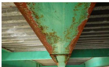
桁の腐食
