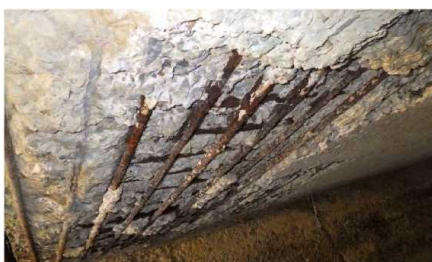
床版の鉄筋露出
