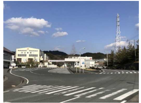
▲北戸綿工業団地
