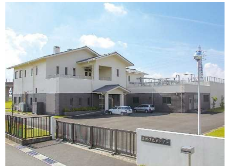
▲森町浄化センター
