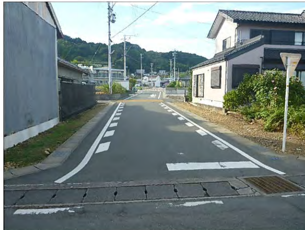
整備後(街区道路築造工事)
