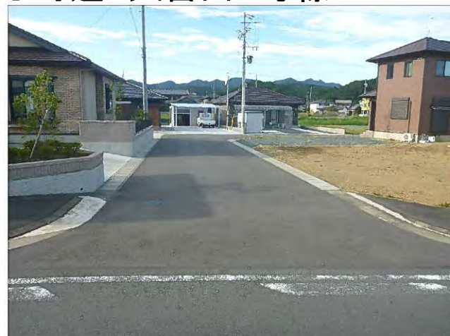
整備後(街区道路築造工事)
