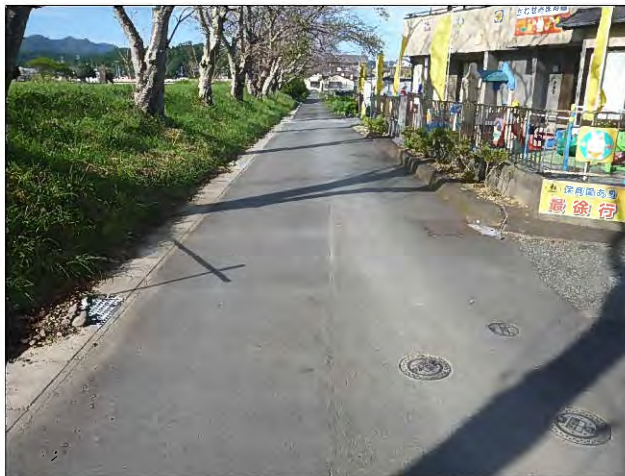
整備後（水道管耐震化工事）
