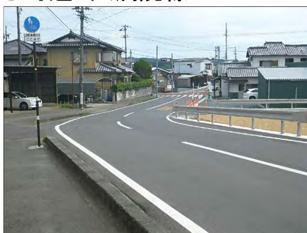
整備後(舗装工事)
