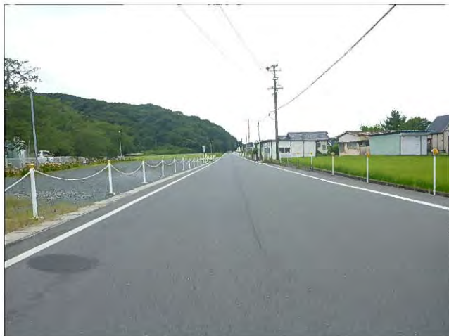
整備後(拡幅改良工事)
