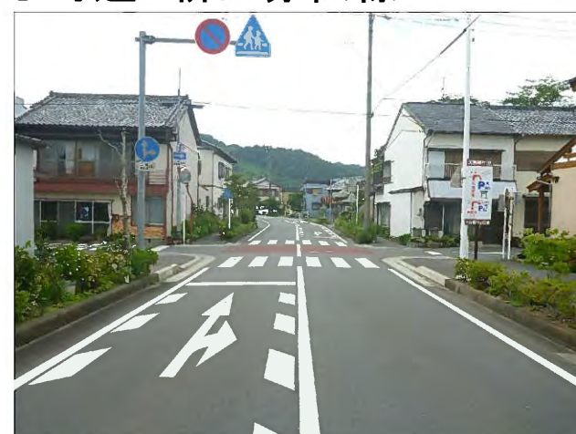
整備後(舗装工事)
