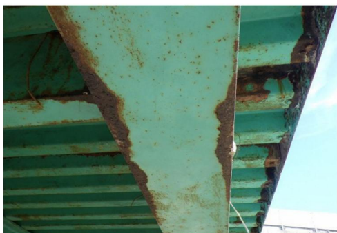
桁の腐食
