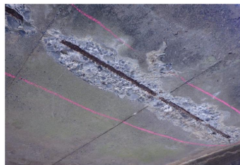
床板の鉄筋露出
