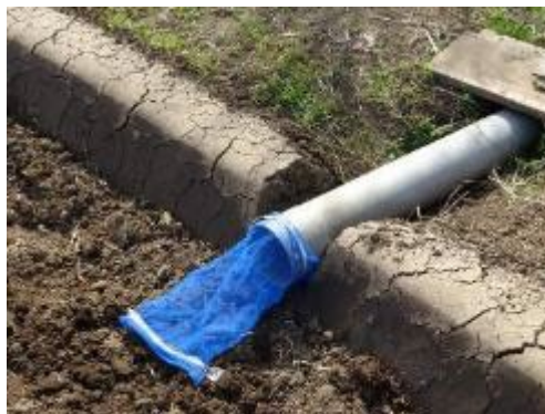
取水口への網の設置
