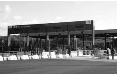
新東名高速道路[森掛川IC]開通
