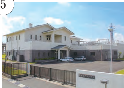
森町浄化センター
