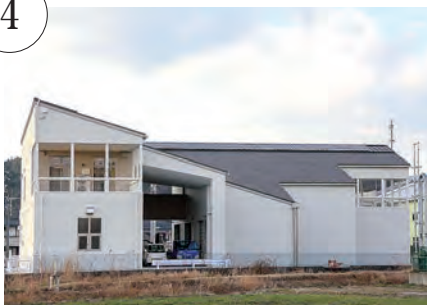
森町拠点防災倉庫
