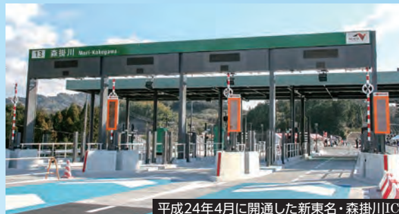
平成24年4月に開通した新東名・森掛川IC
