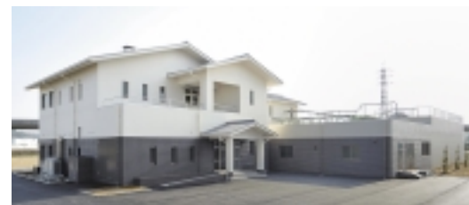
森町浄化センター
