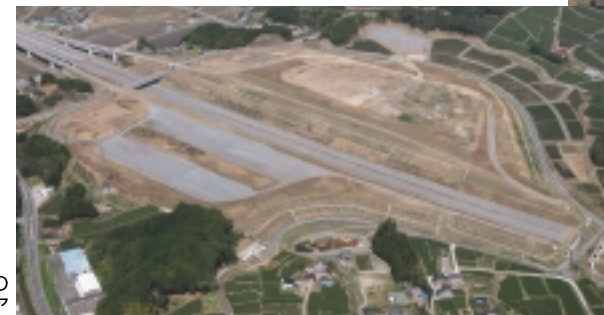
建設中の森町パーキングエリア
