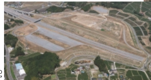
建設中の 森町パーキングエリア
