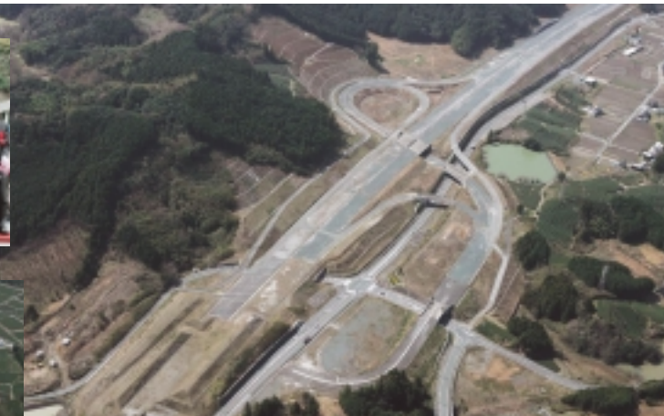
建設中の森・掛川インターチェンジ
