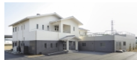
森町浄化センター
