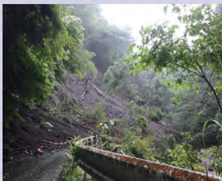
土砂が道路に流出(亀久保市内)
