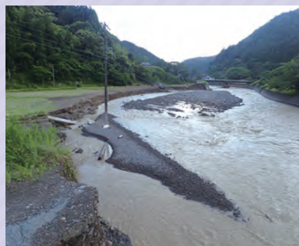
堤防が決壊して電柱が倒壊(黒石市内)
