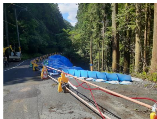
県道袋井春野線 大型車両通行止め (田能入口バス停付近)
