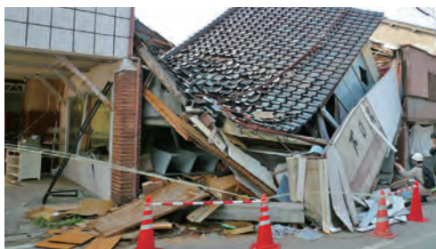
住宅の倒壊(2007.3能登半島地震)
