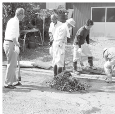
道路側溝の清掃作業
