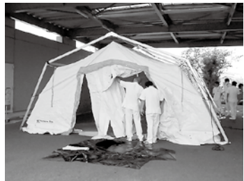
完成した大型テント
