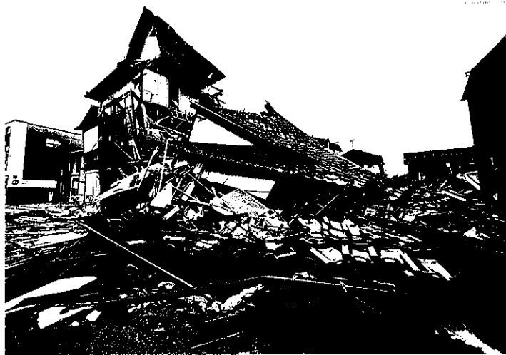
全壊した木造家屋（輪島市）
