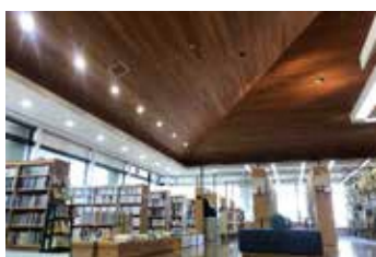
改修を行う森町図書館天井
