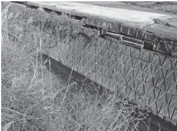
第2小藪川の損傷した護岸
