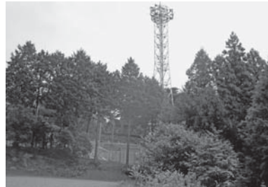
防災行政無線 城ヶ平基地局
