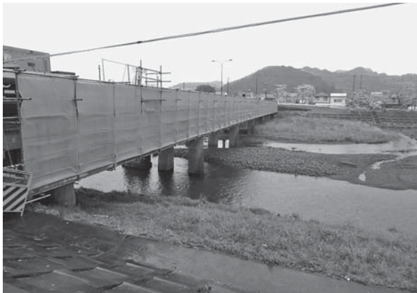
点検・修繕を行っている天森橋
