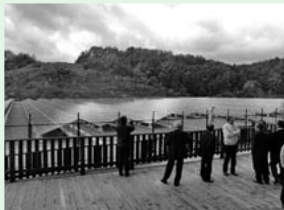
太陽光発電所 メガソーラーいいた
