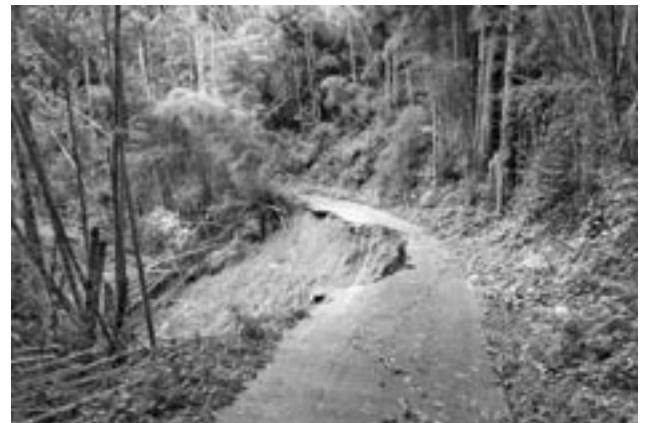
台風18号により崩れた道路(橋地内)
