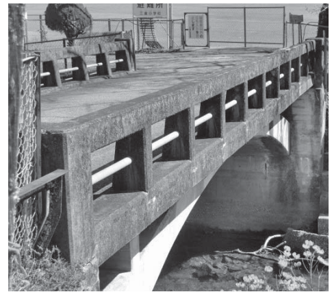
長寿命化計画により補強する友愛橋(三倉)
