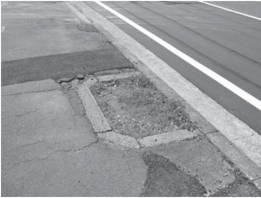
老朽化し、ひび割れた歩道と空いた植樹ます
