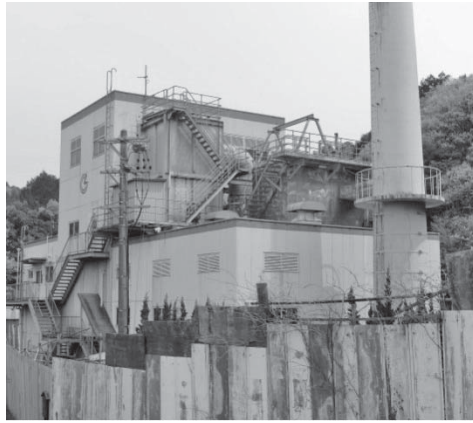
閉鎖した(元)森町清掃センター(向天方)
