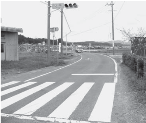
県道山梨一宮線(谷中駐在所付近)
