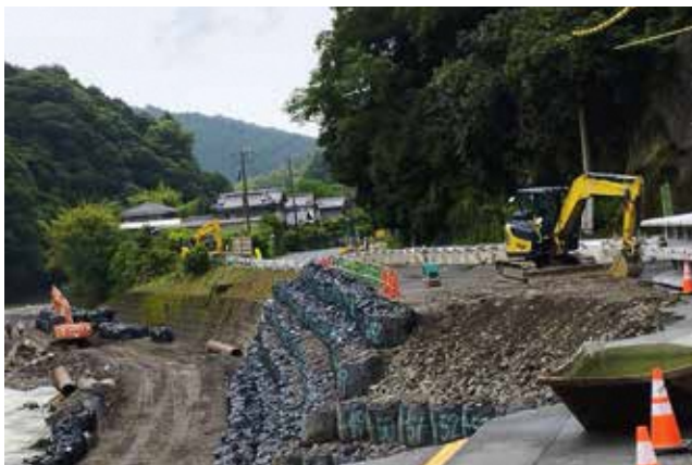
復旧が進む工事現場（黒石地区）
