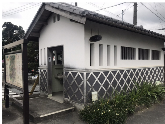
築30年以上経過した新町公衆トイレ
