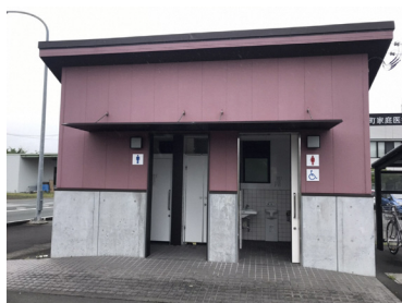
築7年の森町病院前駅公衆トイレ
