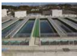
遠州水道 寺谷浄水場(磐田市)
