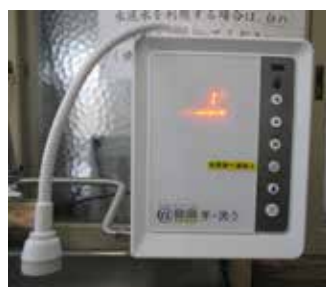
役場の1階に据え付けられた除菌電解水給水機
