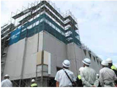
建築が進む袋井消防庁舎
