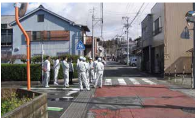
下水道整備予定箇所の確認
