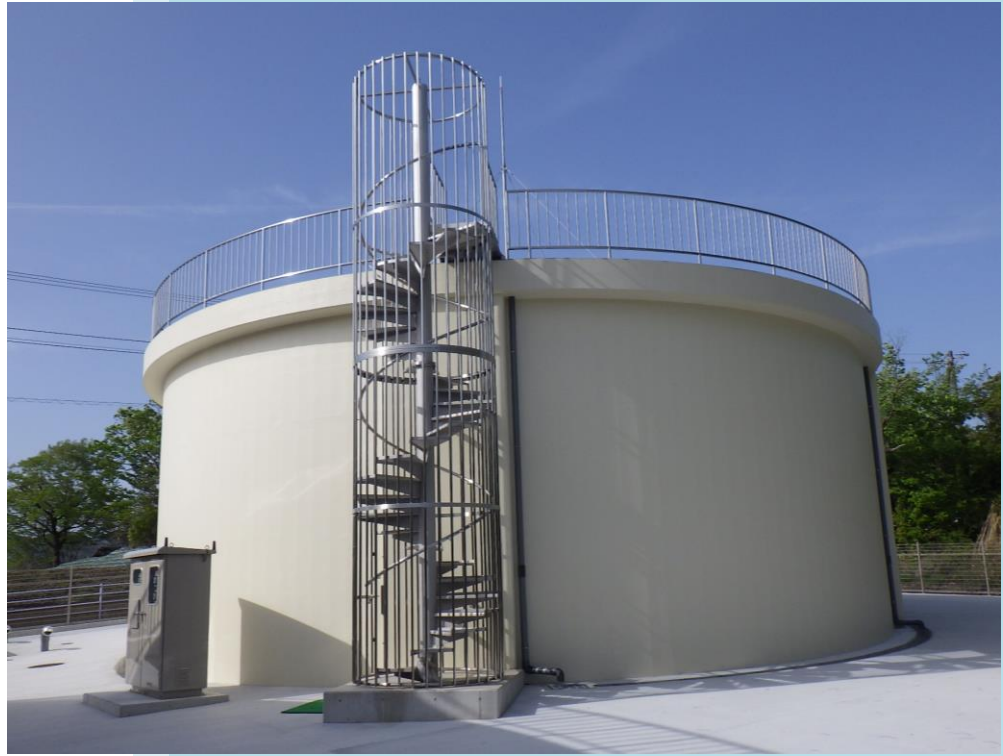
北部配水池 森町森地内
