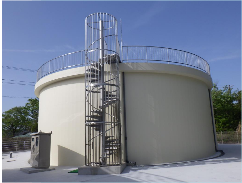
北部配水池 森町森地内
